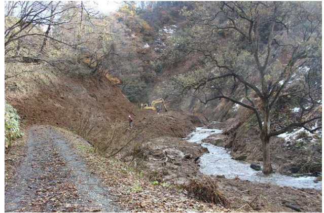
第 3 図 崩落土砂の堆積状況 清川左岸の市道を被覆し、崖の上まで到達。
