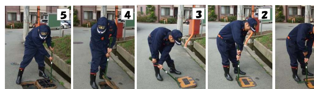
図3のようにテコを利かせてふたを浮かせ、T字ハンドルでそのまま持ち上げ(図4)、反転させる。足元に注意。□ 1に入れ、図2のように90度回すとロックが外れる。
