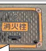
辻川区では最も設置箇所が多い消火栓(24箇所)。比較的幹線道路に多い。ふたを開けるためのバル孔が左右2箇所にある。
