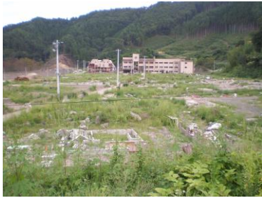
【崩壊した唐丹小学校】
